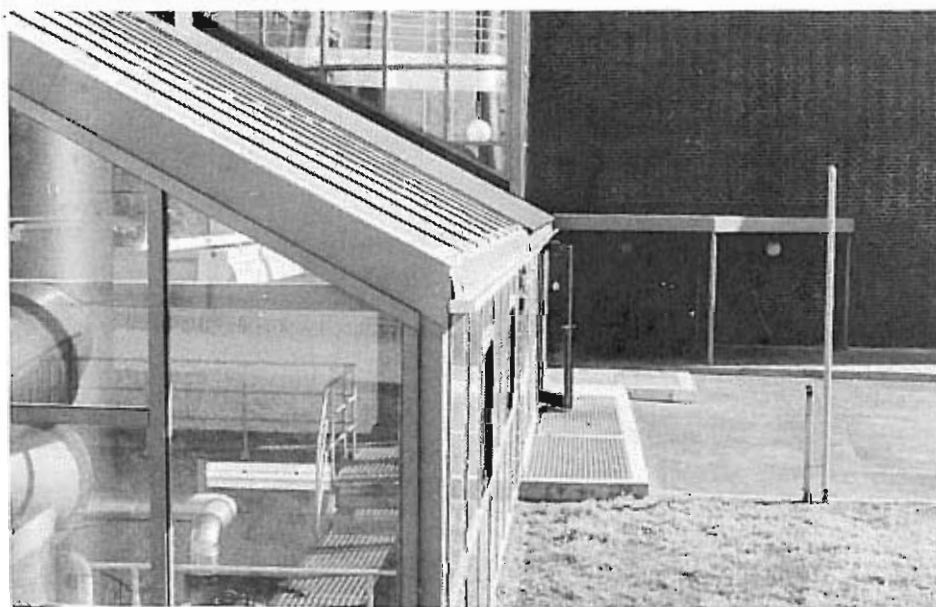
Fig. 9.2 Eksempel på renne
