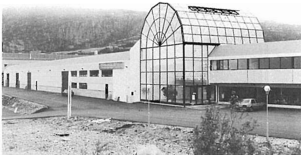
Fig. 9.3 Inngangspartier må beskyttes mot ras
