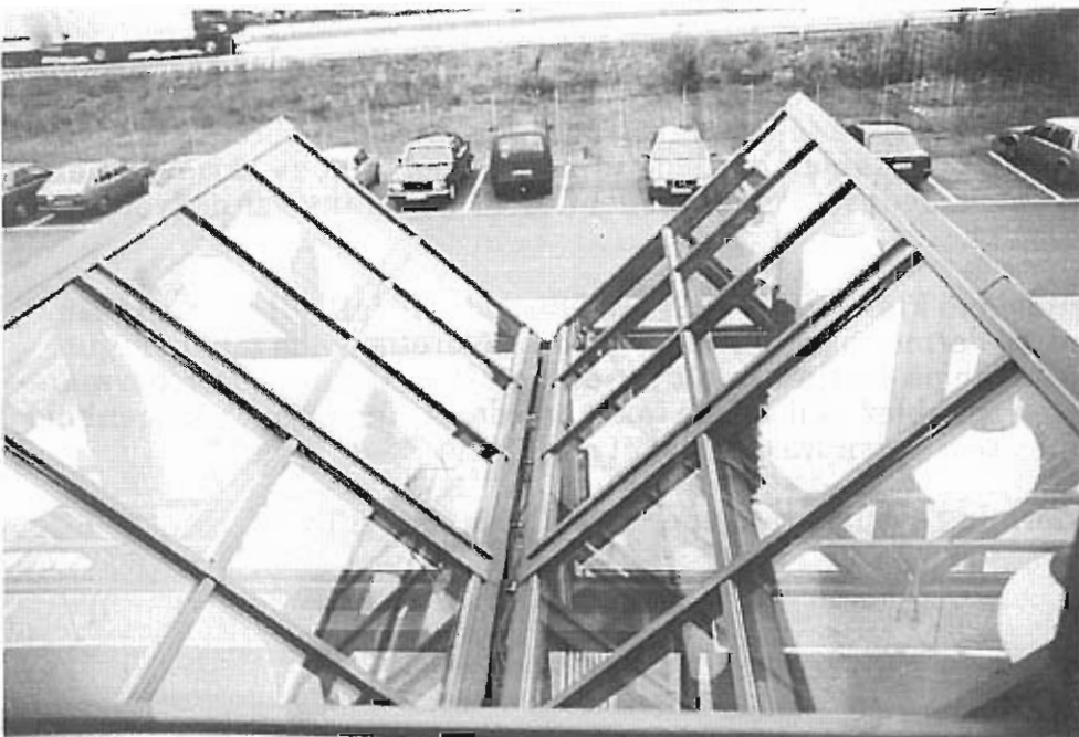
Fig. 9.9 Renne med liten kapasitet
