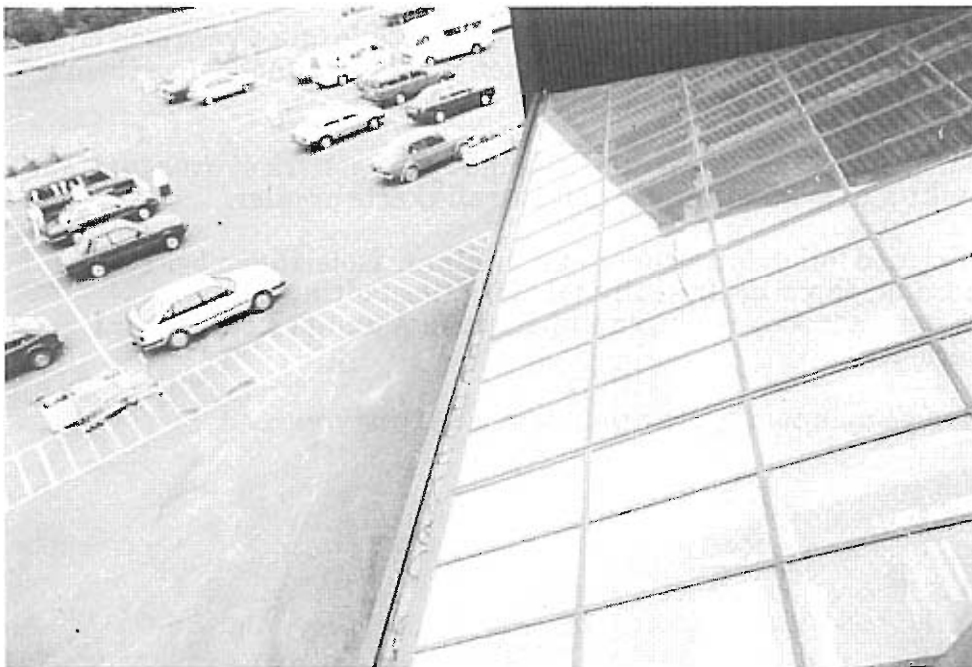
Fig. 9.6. Renne i overgangen tak/vegg
