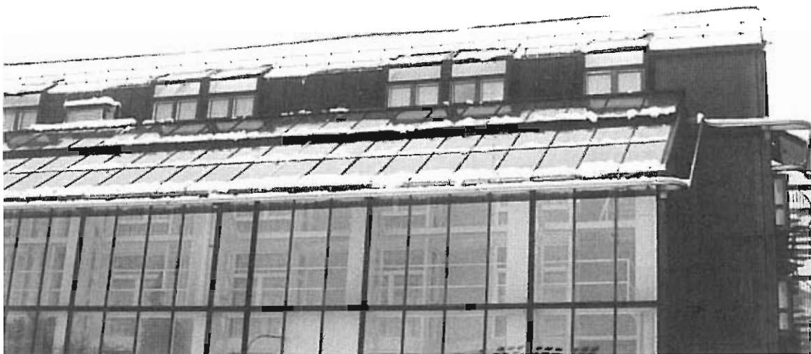
Fig. 2.5 Snøfangere hindrer videre avglidning av snø
